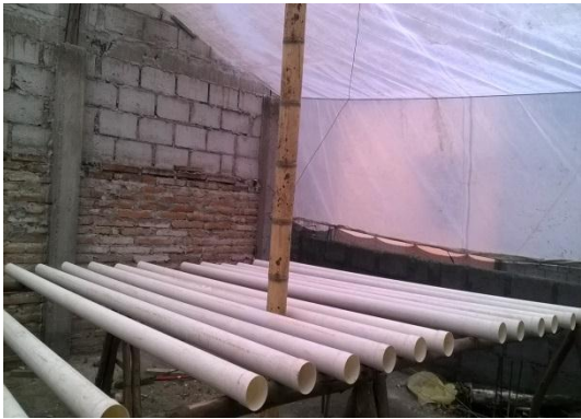
Figura 2. Adecuación sistema NFT.
