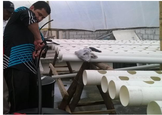
Figura 6. Instalación bomba de agua.
