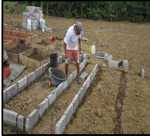
Fig. 6. Construcción de los contenedores
