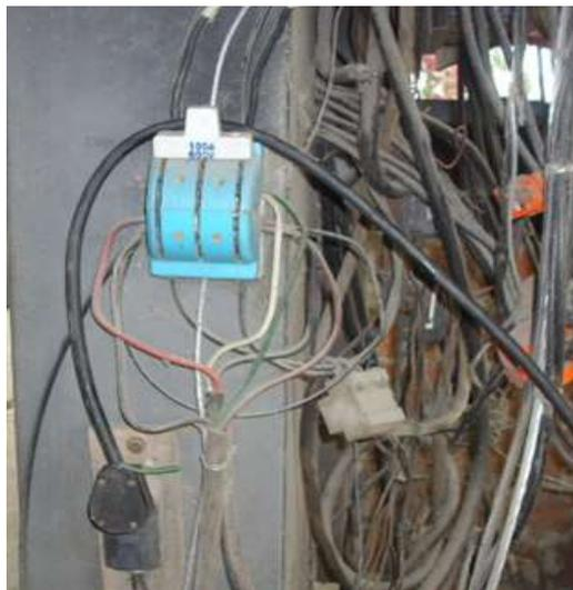
**Ilustración 3 Dispositivo de protección no sujetado**
