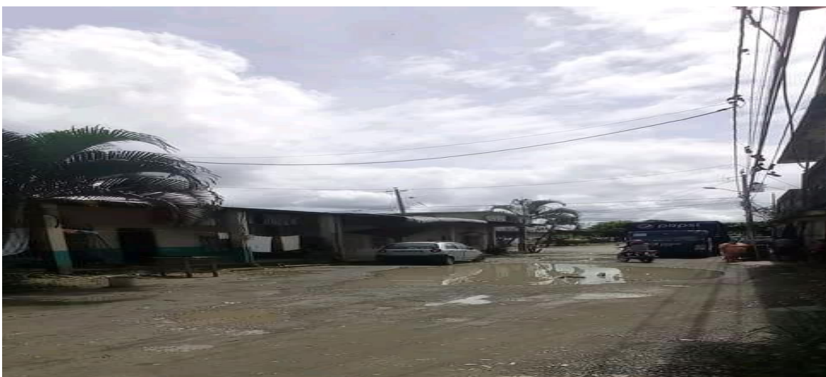
Tendido de cables en una de las calles del sector
