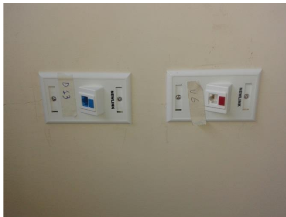
Figura 18: Faceplates NEWLINK Simple Azul Datos/Rojo Voz Elaborado por: Investigadoras
