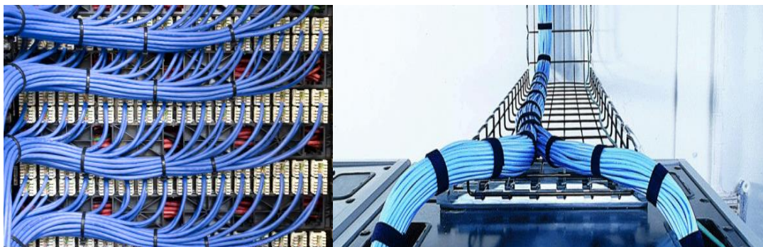
Figura 37: Tendido De Cables Elaborado por: (Tecnico ADC Informe [Imagen])
