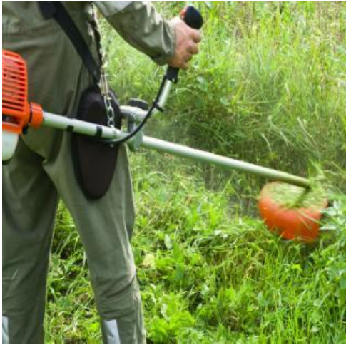
Limpieza del terreno
