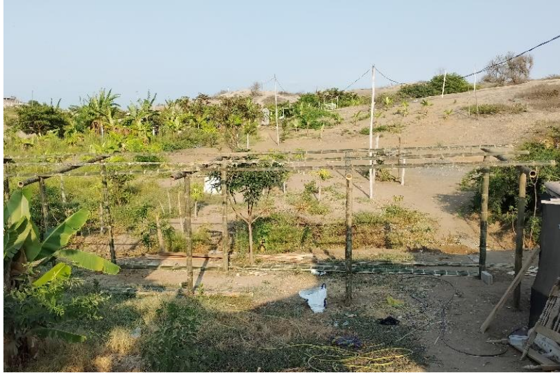
Construcción de los galpones para los pollos de engorde
