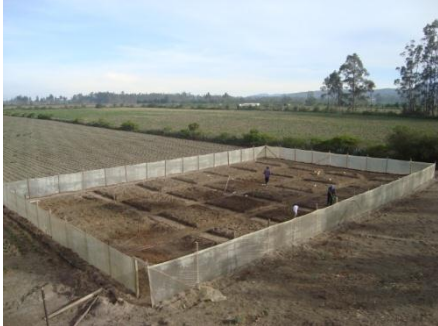
Fig 1. Preparación del terreno
