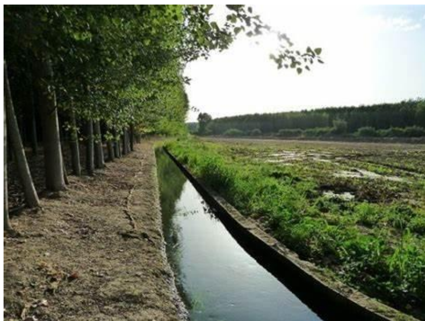
Ilustración 4. Canales de agua
