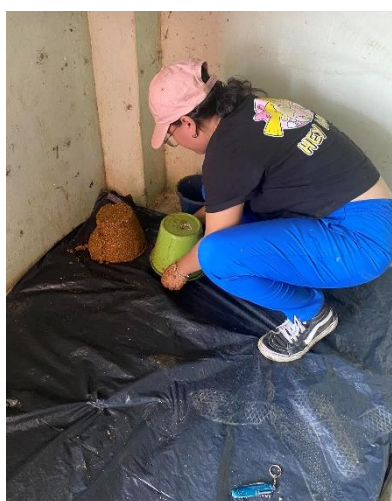
Ilustración 5 Vaciado de los bloques.
