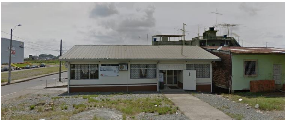
Exteriores del centro de salud "Lucha Obrera" del cantón Babahoyo
