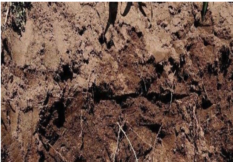
Figura 2. Compactación de suelo arcilloso
