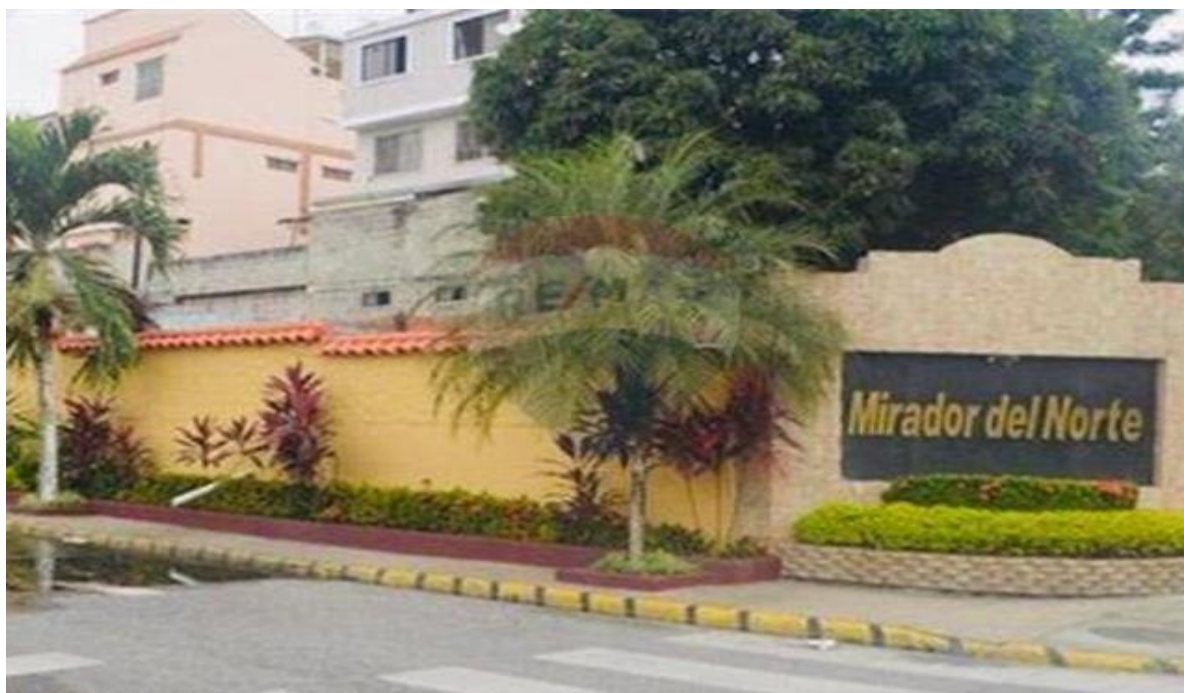
Anexo 2. Ingreso Principal de la Ciudadela "Mirador del Norte". Información adaptada de la investigación de campo. Elaborado por el autor.
