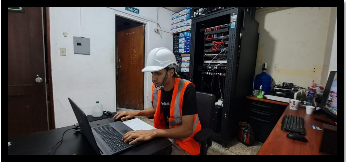
Figura 2 Revisando y Analizando la Cámaras de seguridad De Adaelectric
