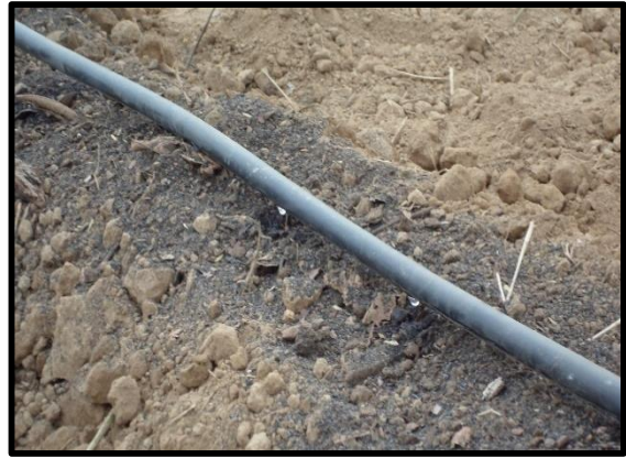
Foto 4. Prueba del sistema de riego por goteo.
