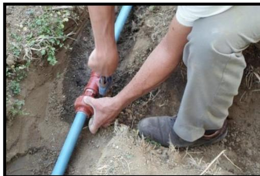
Foto 4. Enterramiento de tuberías y equipo de riego por goteo.
