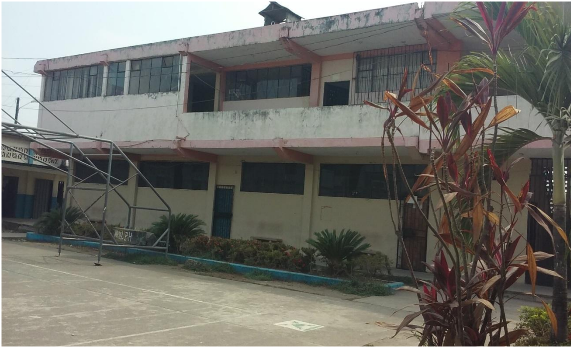
Edificio Central de la Unidad Educativa “Diez de Agosto” Vinces.
