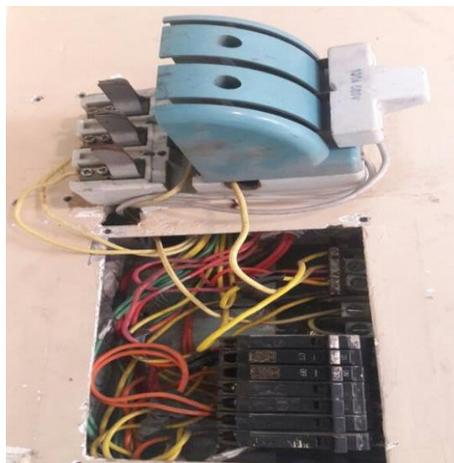
*Figura 1 Condiciones actuales del panel de distribución de cargas y disyuntor principal*
