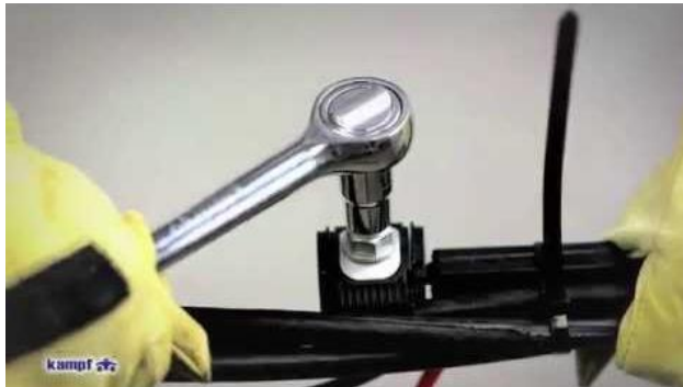
Fig. 5 (Ajuste de un conector dentado DCNL2)
