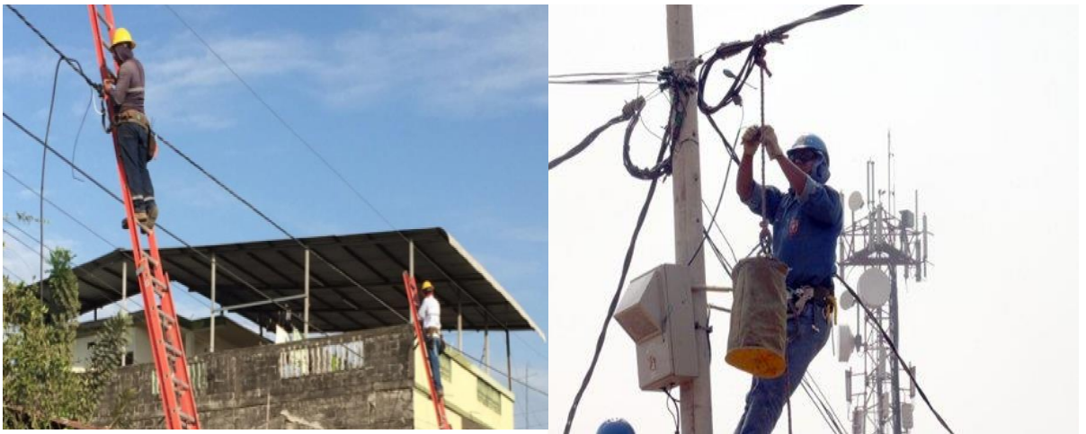
Fig. 10-11 (Instalación de acometida aérea)
