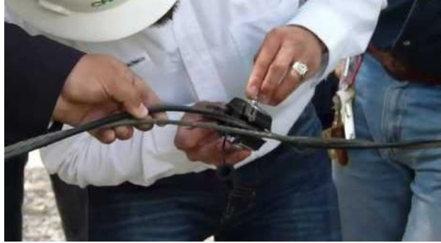
Fig. 4 (Instalación de conector dentado DCNL2)
