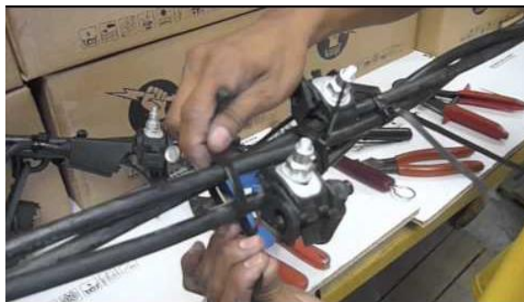
Fig. 3 (colocación de precintos para fijación de acometida)
