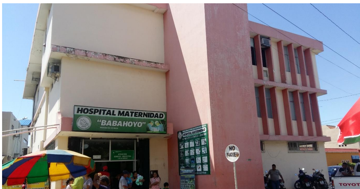
Imagen 3 Instalación del Centro de Salud Enrique Ponce Luque (Maternidad)
