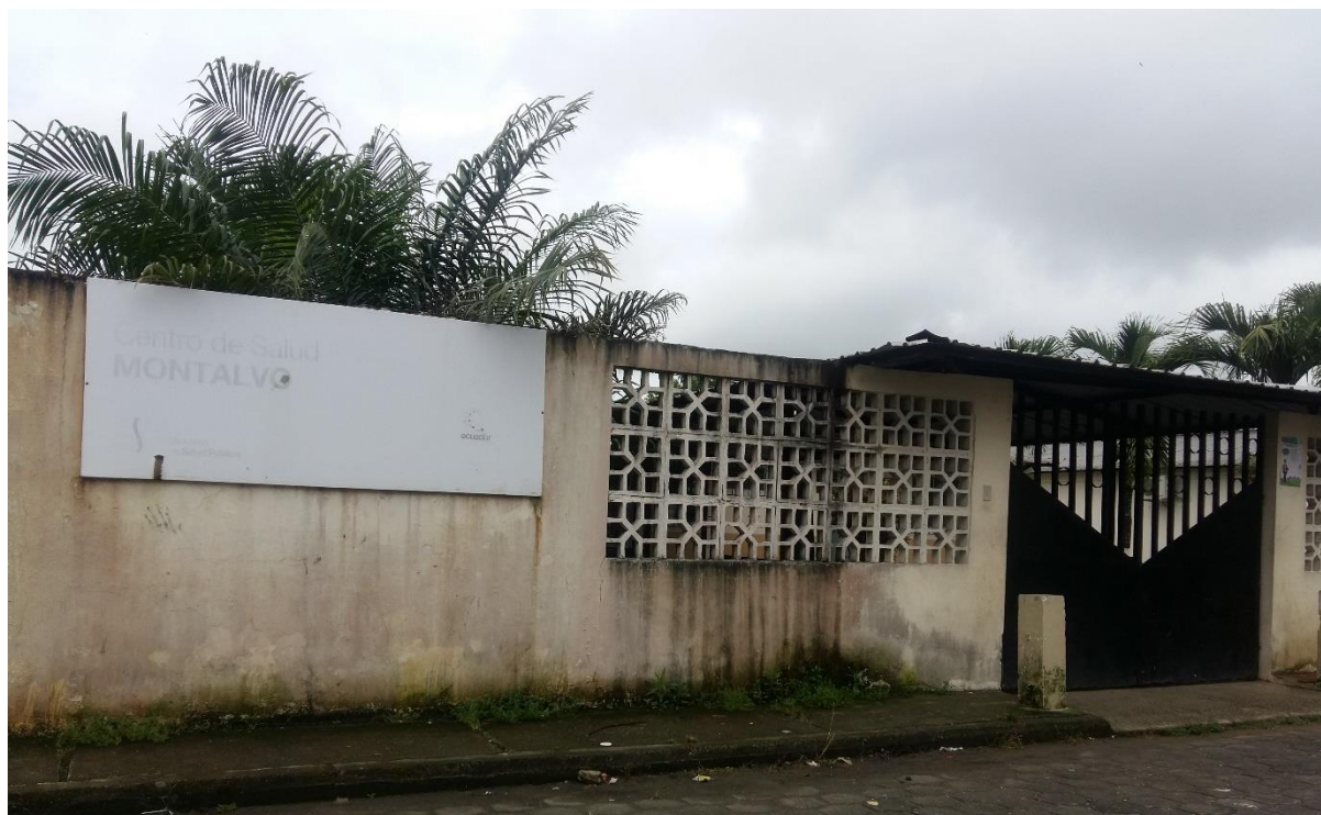
Imagen 8 Instalación Centro de Salud Montalvo
