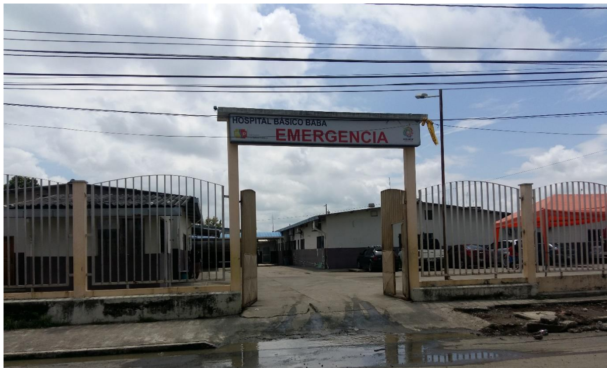
Imagen 4 Entrada de emergencia del Hospital Básico de Baba
