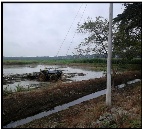
Fig. 1. Preparación del terreno
