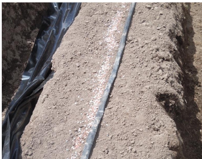
Figura 12. Instalación de sistema de riego.
