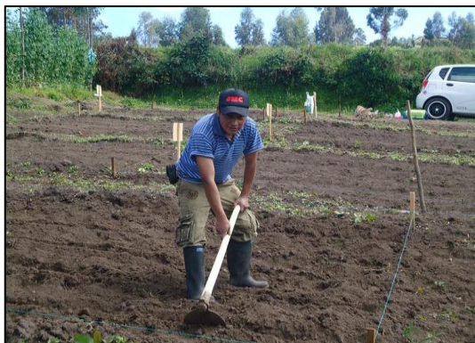
Figura 10. Nivelación del terreno.
