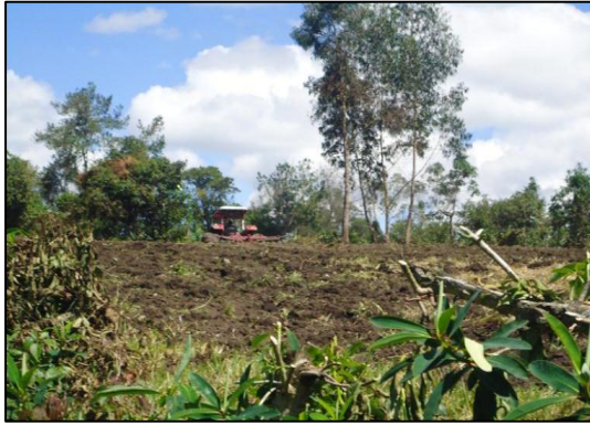
Figura 2. Preparación de suelo.
