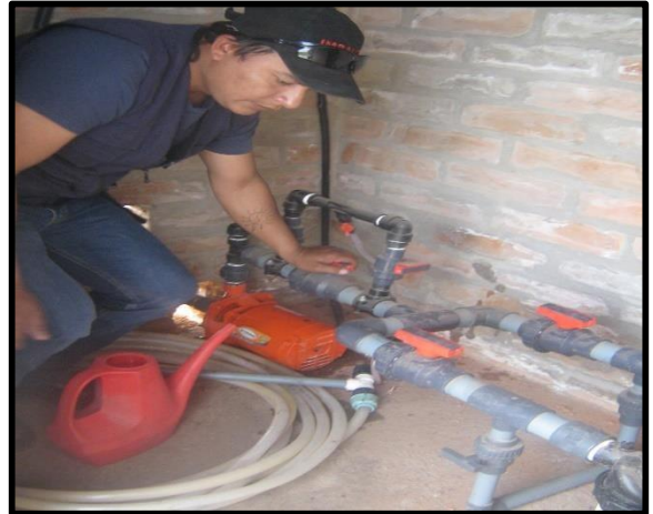
Fig. 2. Instalación de bomba de riego
