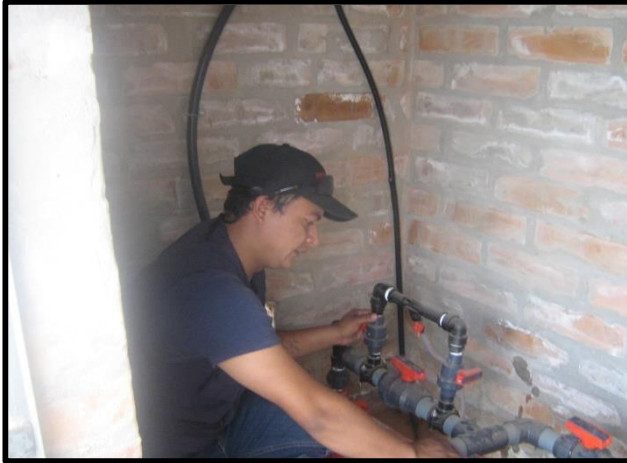
Fig. 1. Instalación de fertirrigación
