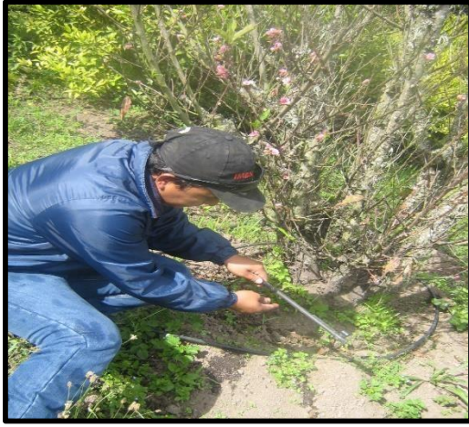
Fig 11. Instalación de aspersores
