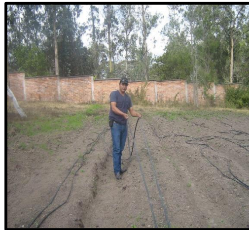
Fig 7. Instalacion de goteo a campo abierto
