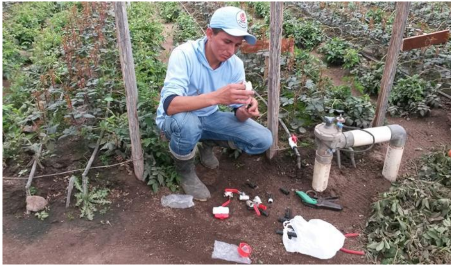
Foto 4. Instalación sistema de riego independiente para el ensayo
