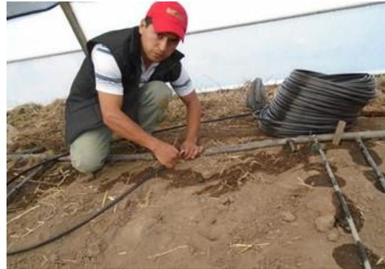
Figura 4. Instalación del sistema de Riego.
