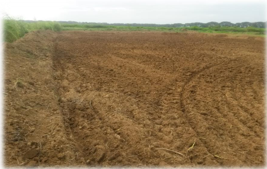
Figura 2. Preparación del terreno.
