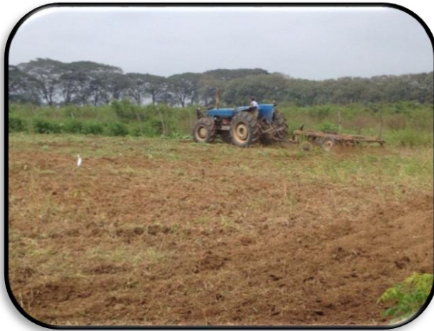
Fig. 1. Limpieza del terreno
