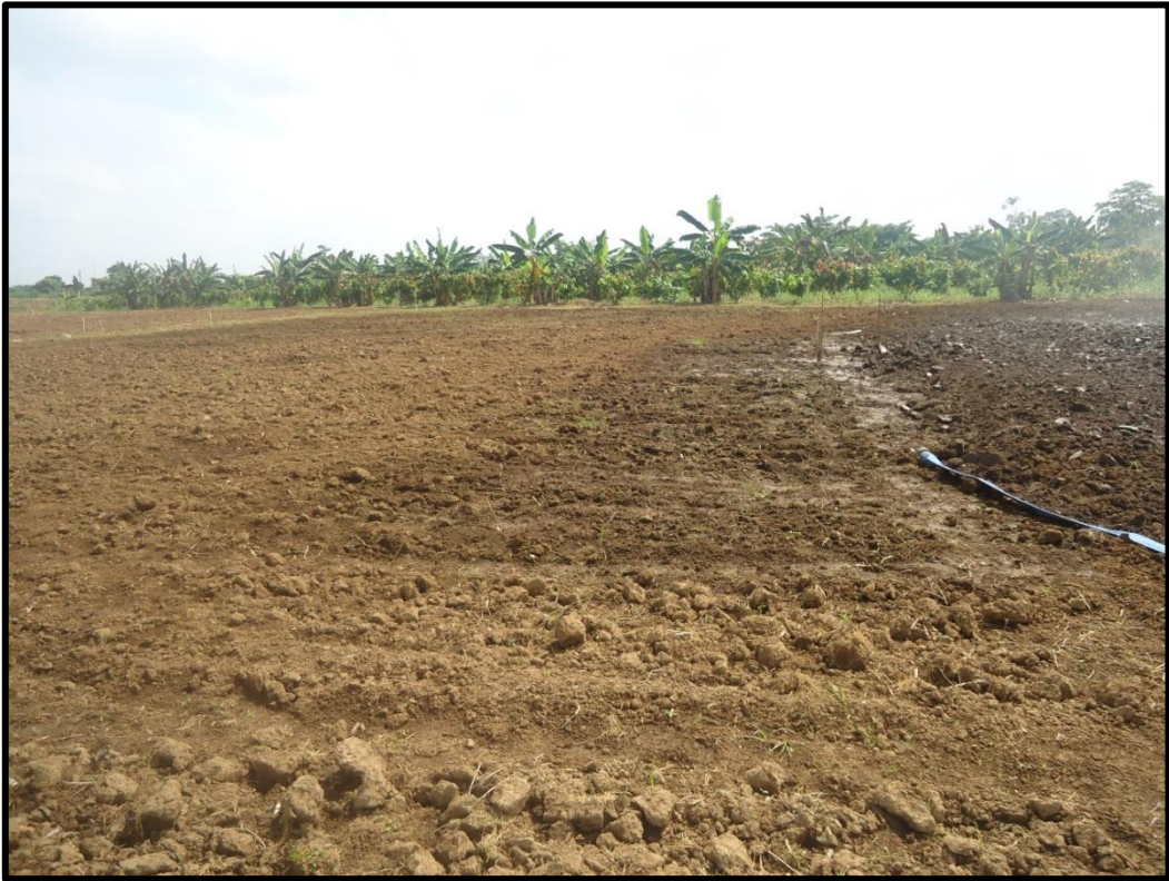
Preparación de terreno
