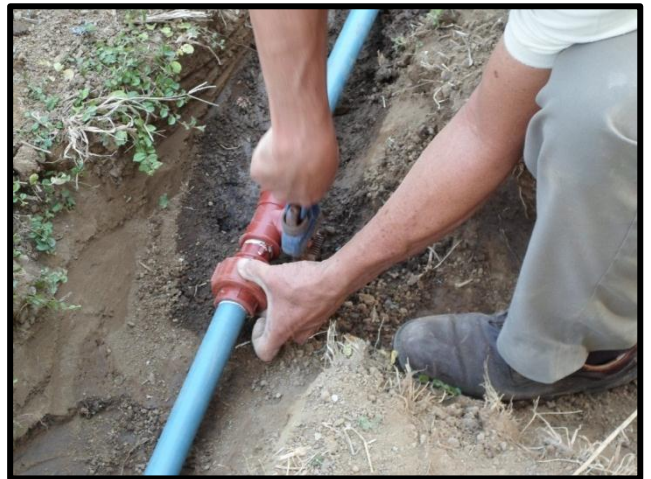
Fig. 4. Instalación del sistema de riego
