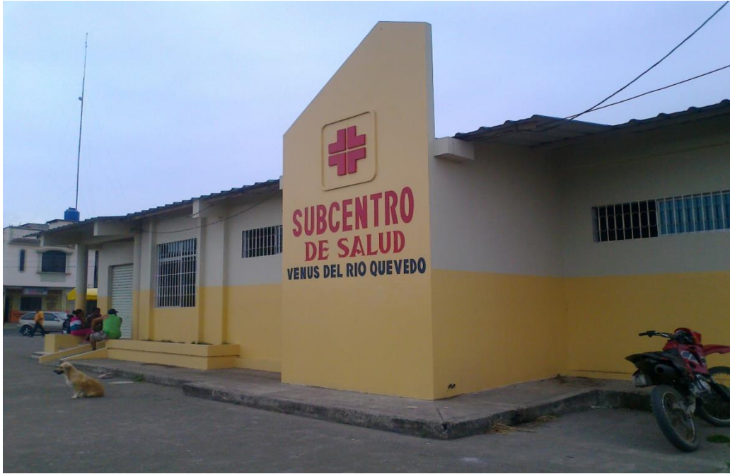
Edificio del Subcentro de salud Venus del Ríos de la ciudad de Quevedo.
