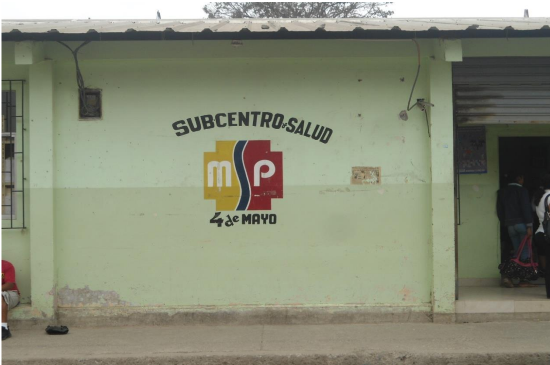
INSTALACIONES DEL SUB CENTRO DE SALUD 4 DE MAYO
