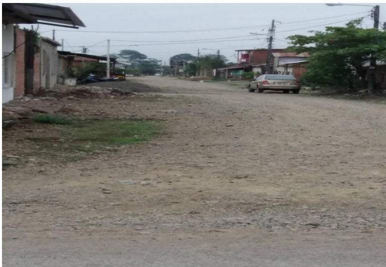
Foto 2: Avenidas de acceso principal en mal estado.
