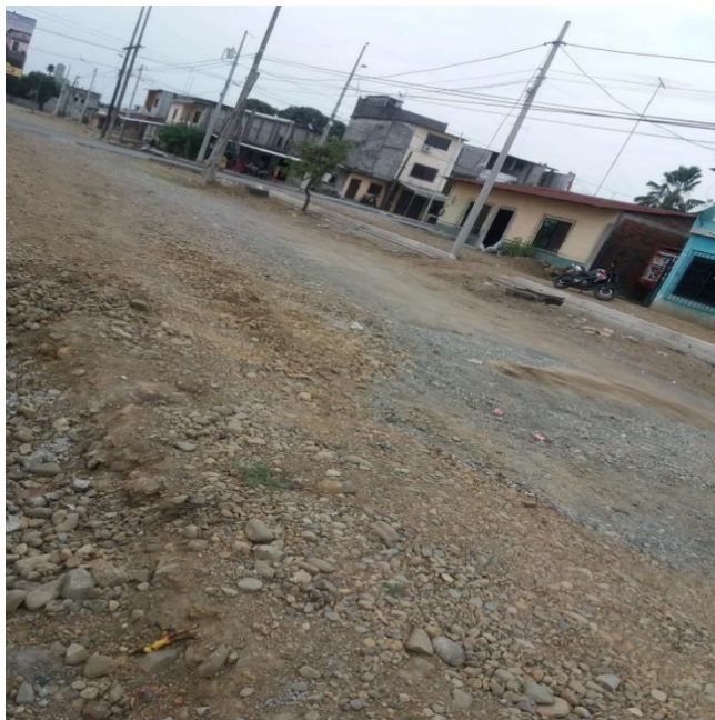
Foto 6: calles de la parroquia el Salto en mal estado
