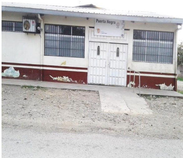
Foto 4: Subcentro de Puerta Negra
