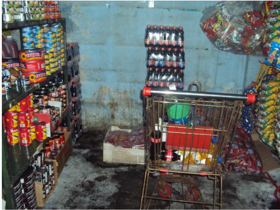
Mal estado de ambiente e infraestrutura
