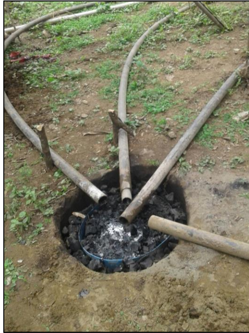
Figura 6. Pozos de filtro para residuos líquidos en la Asociación de Desarrollo Agropecuario "La Esmeralda". Plan de Gestión Socio-Ambiental
