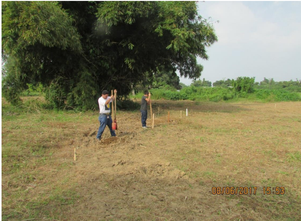
Figura 3 Estaquillado de terreno
