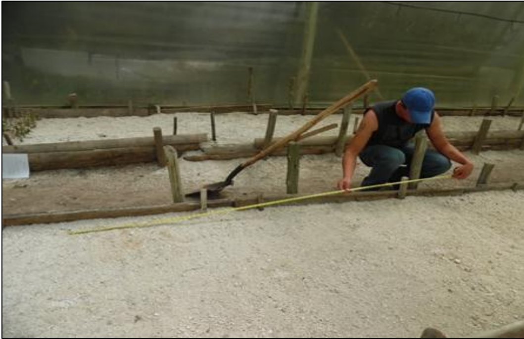
Fotografía 1. Construcción de camas.
