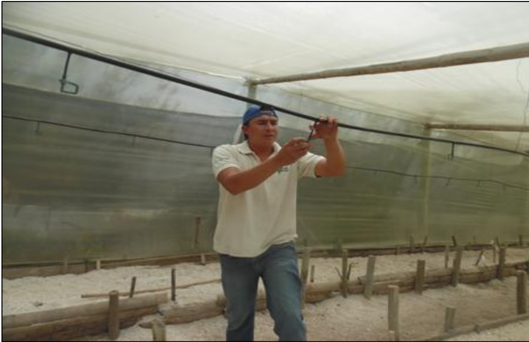
Fotografía 9. Instalación del sistema de riego.
