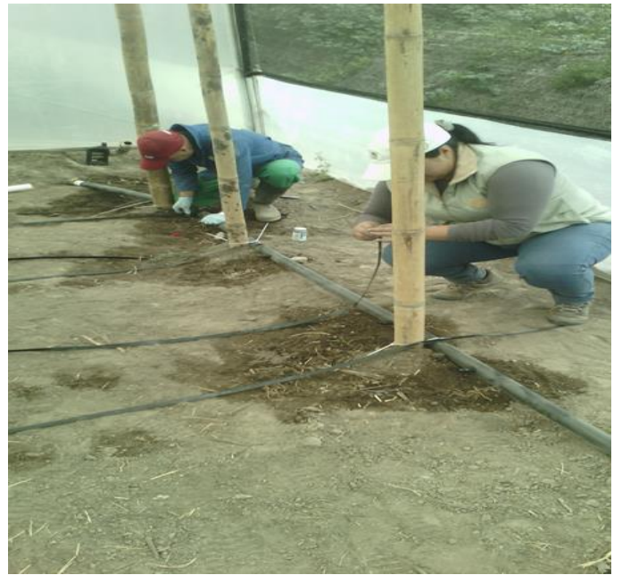
Imagen 2. Instalación del sistema de riego UTB.FACIAG.2018.
