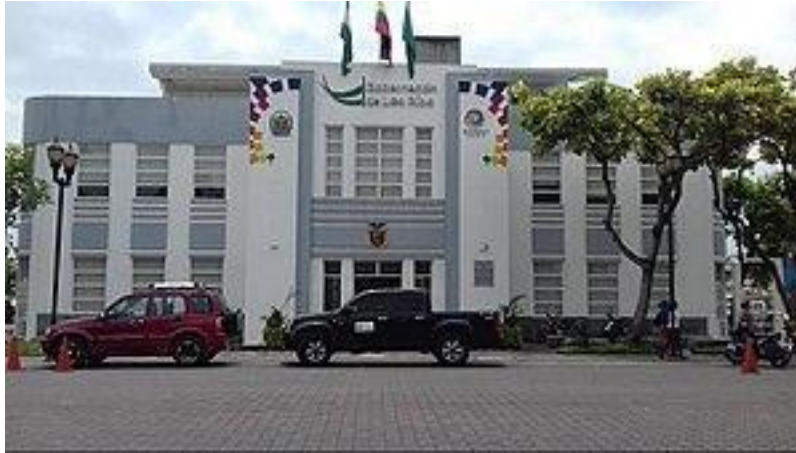
Figura 1 Edificio de la Gobernación de la Provincia de Los Ríos.
