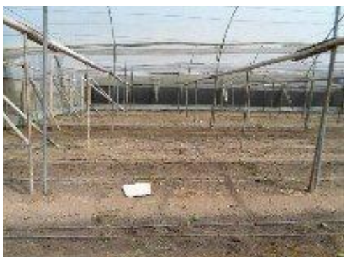
Figura 1. Preparación del suelo
