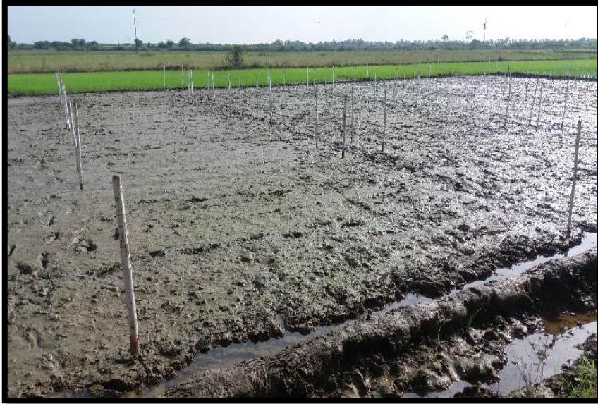
Figura 7. estaqueo del terreno.
