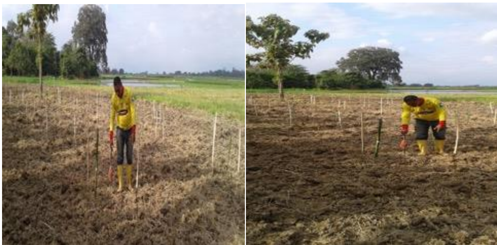
Fotografía 2. Nivelación del terreno
