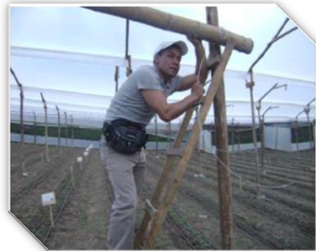
Instalación del sistema de tutoreo
