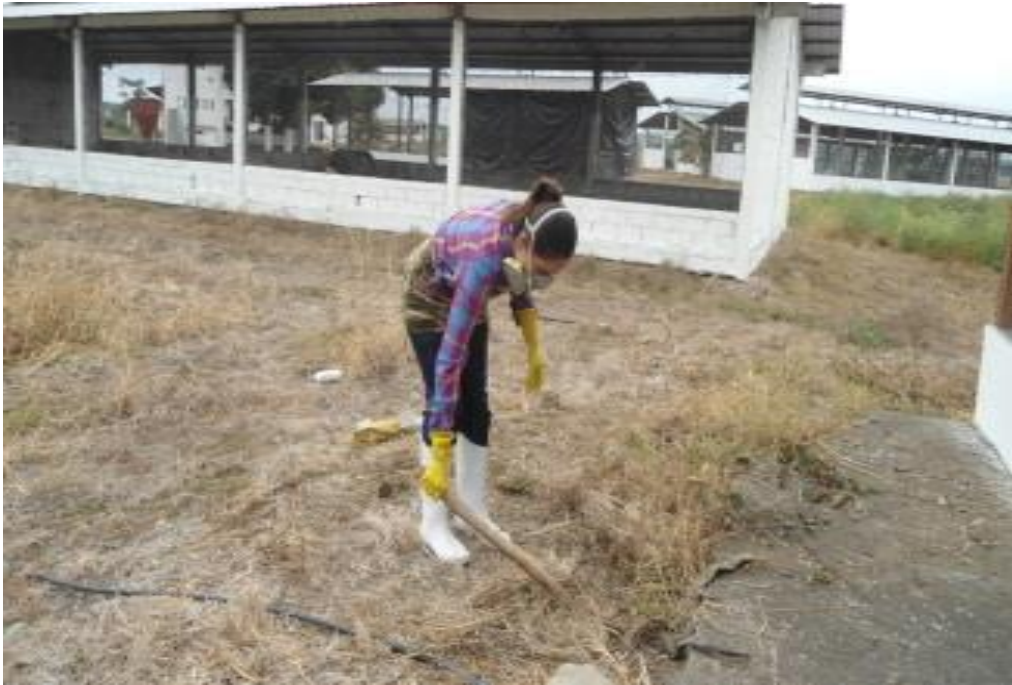
Fotografía 01: Limpieza en seco
