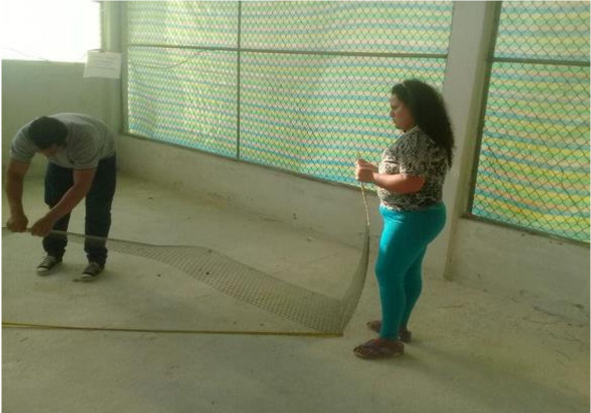
Ilustración 3: Construcción de cuarteles UTB – FACIAG
