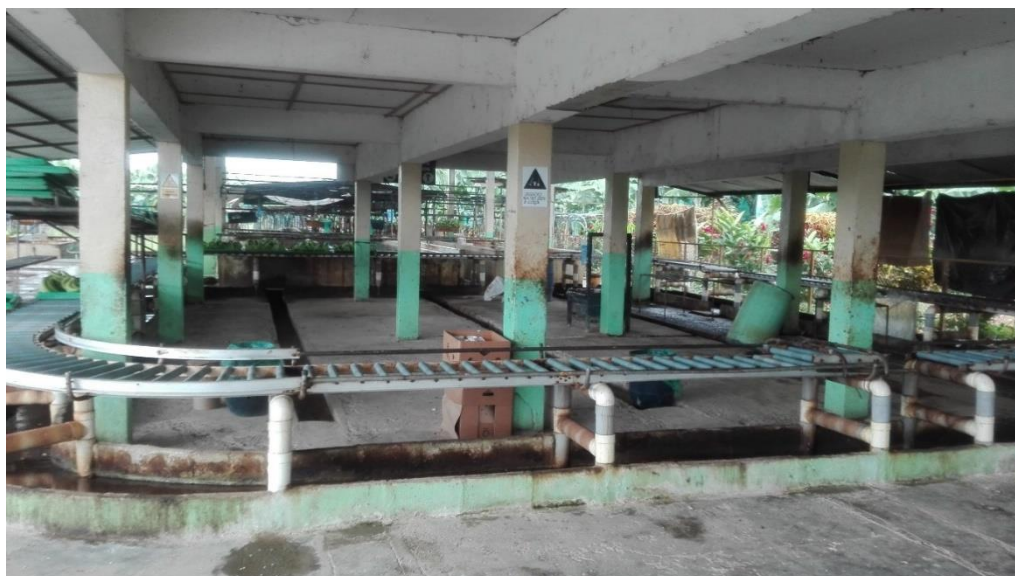
Figura 614: Empacadora de banano Sector Palizada 1
