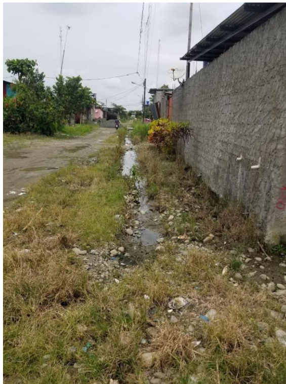
Anexo 5. Agua estancada en el sector Puertas Negras
