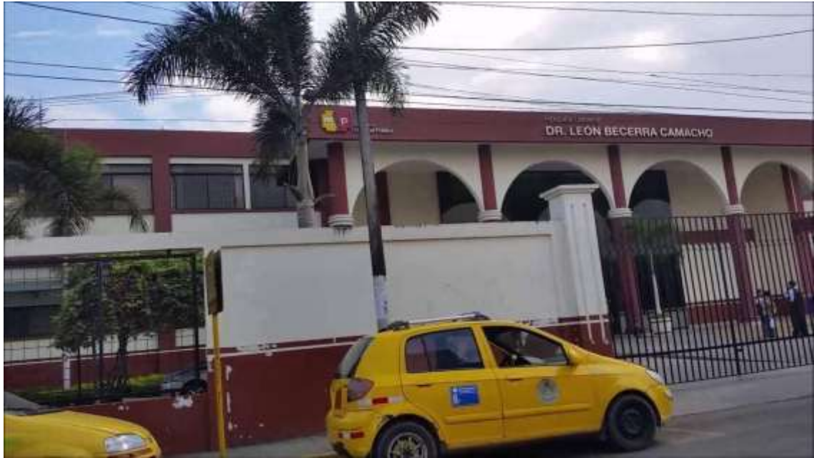
HOSPITAL LEÓN BECERRA CAMACHO DE LA CIUDAD DE MILAGRO
