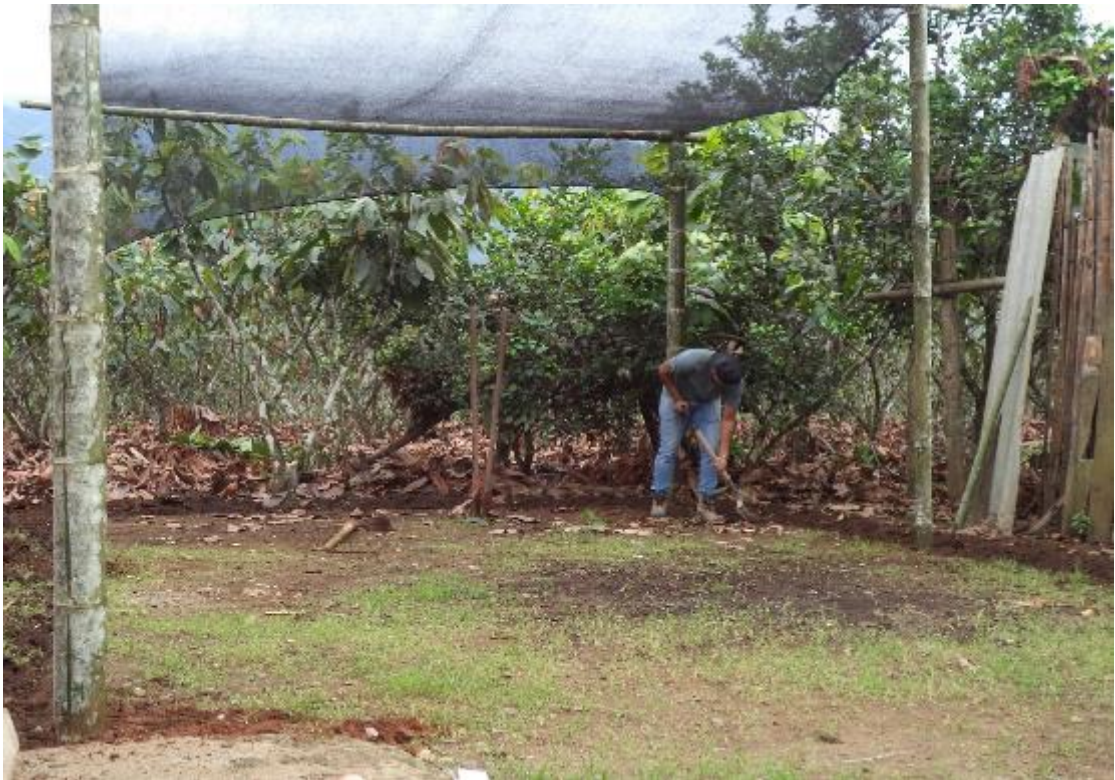
Imagen 1 construcción del área experimental
